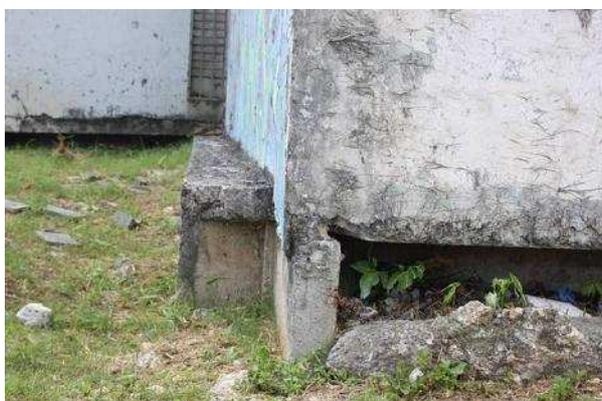
Figure 4-4 : Tassement du remblai
