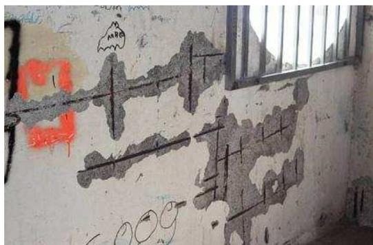
Figure 4-5 : Corrosion sur les voiles porteurs (1)
