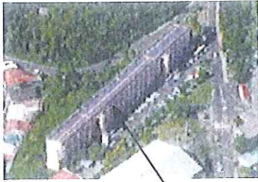
Résidence Balisier à Fort de France
